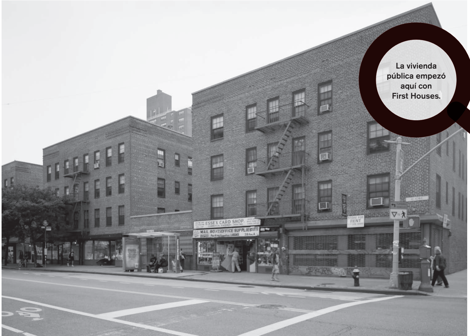
Vivienda pública, Lower East Side
